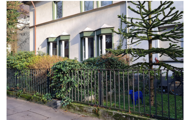
Das „bay window“, eine Ausluchtung in der Fensterfront zur Straßenseite, ist charakteristisch für viele Straßenzüge in britischen Vorortgemeinden.
