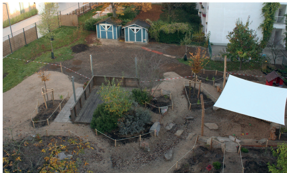
Bald ist es komplett bepflanzt: Das neue Außengelände ist fast fertig.
