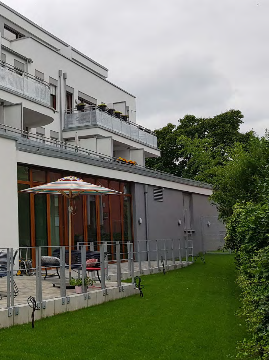
Blick aus dem Garten im neuen Gebäude: Unten im Fliestedenhaus befinden sich Gemeinderäume und die Tagespflege, oben im Benderstift wohnen Mieter im betreuten Wohnen.
