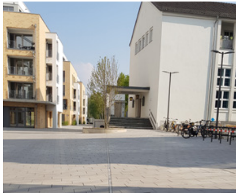
Eine Eisenbahnschiene in der Pflasterung markiert die Grundstücksgrenze.
