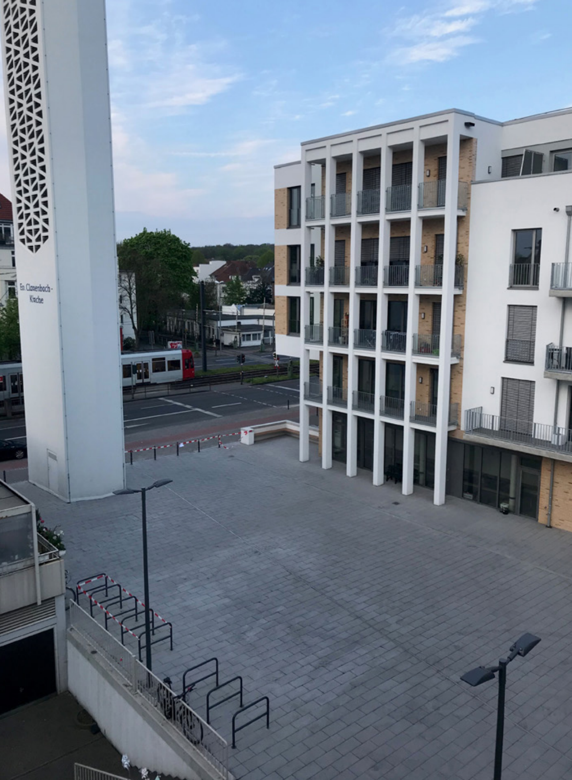
Der neue Clarenbachplatz mit Glockenturm: Fotografiert von einem Balkon oberhalb des Kirchsaals.
