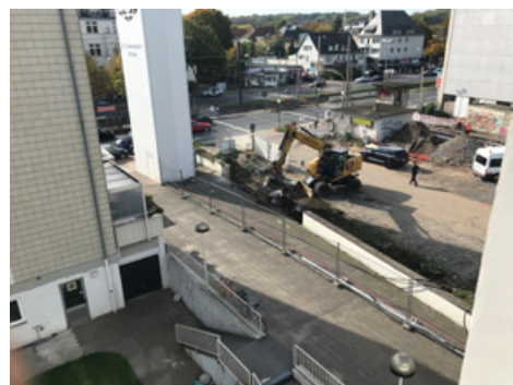
Die Bauarbeiten auf dem Clarenbachplatz haben 2018 begonnen. Noch steht im Herbst die Mauer an der Grundstücksgrenze.
