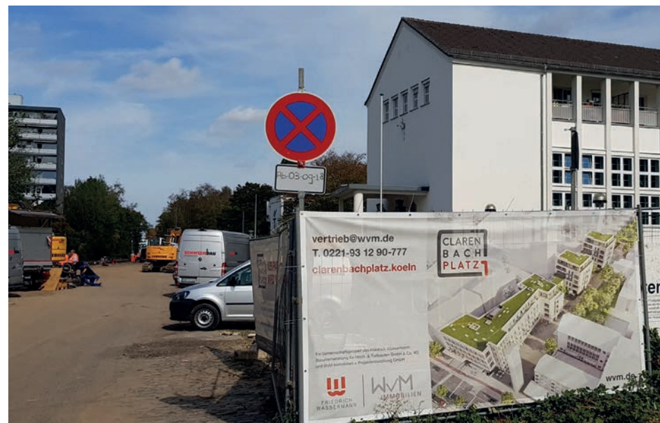
Nach intensiven, meist aber unsichtbaren Vorarbeiten sind seit September dieses Jahres die Arbeiten am zukünftigen Clarenbachplatz unübersehbar. Davon zeugt dieses Foto. Doch auch dessen Motiv ist längst von den täglichen Baufortschritten überholt.
