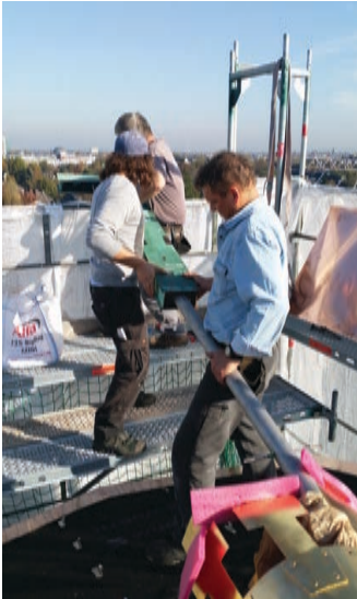
Arbeiter montieren das Kreuz auf dem Edelstahl- rohr...
