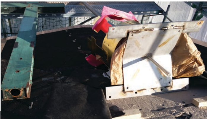
Mit einem Aufzug werden Kreuz und Befestigungsteile auf das Dach des Turms gebracht.
