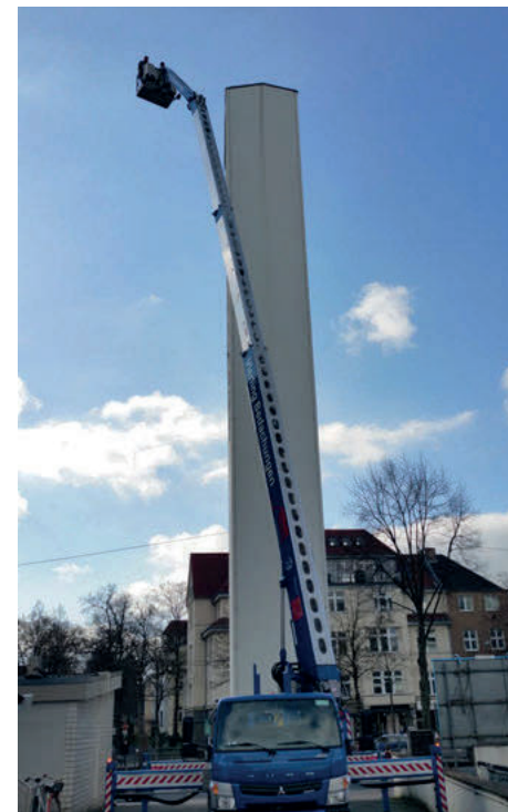
Schadensuntersuchung und erste Ausbesserungsarbeiten in luftiger Höhe.
